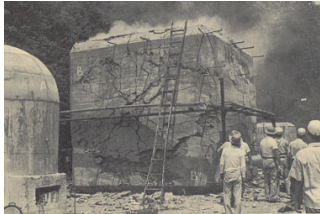
図 9 爆発実験で亀裂を生じた RC 試験体
